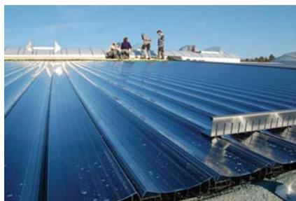
Fig. 28 – Bomatherm: sistema desenvolvido pela Bayer Materials Science para cobertura de prédios que atua como telhado, isolador térmico e coletor solar
